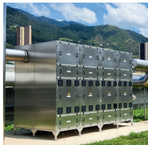
PTAR Aguas Claras- Medellín, Colombia
