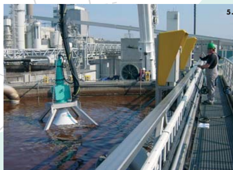
3.-5.: Montaje de un sistema de agitación y aireación HYPERDIVE®
