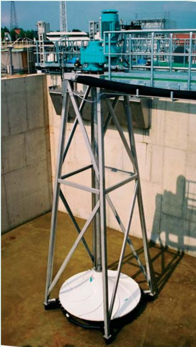
1 sistema de agitación/aireación HYPERCLASSIC® de los 9 existentes en una planta de tratamiento en Bélgica (Industria de papel y pulpa)
