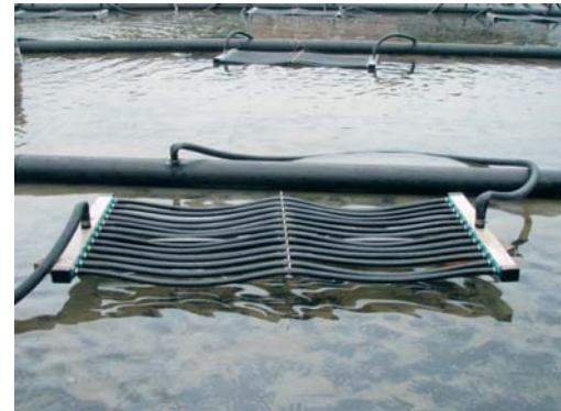
Sistema de aireación E-FLEX ® -FLOAT antes de la puesta en marcha
