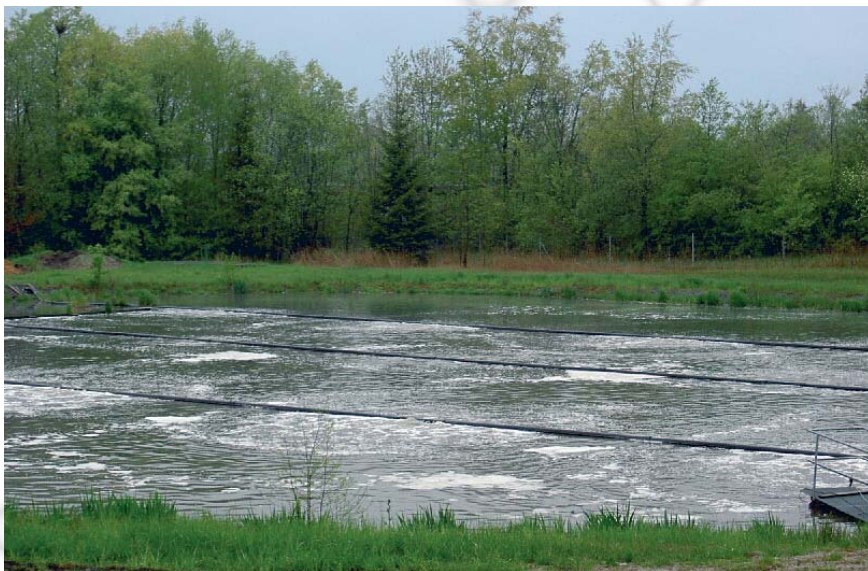
Sistema de aireación E-FLEX ® -FLOAT en una laguna de tratamiento aireada
