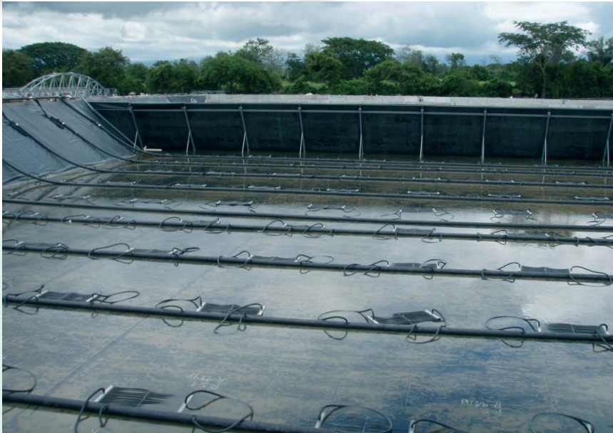
Sistema de aireación E-FLEX ® -FLOAT en un tanque de activación
