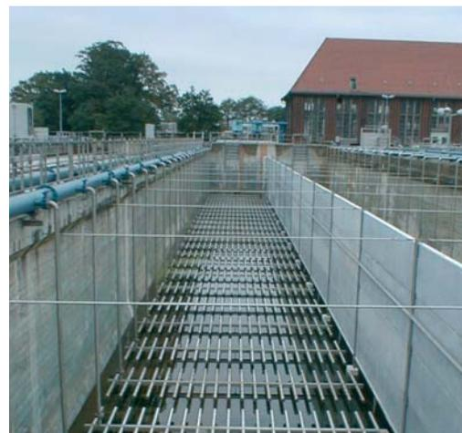
Sistema de aireación **TEX-FLEX**<sup>®</sup> en una planta municipal de depuración de aguas residuales en Alemania.
