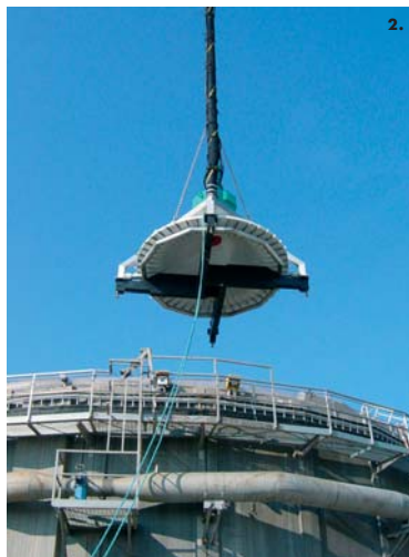
1.-2.: Montaje de un sistema de agitación y aireación HYPERDIVE®
