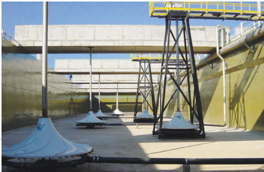
8 sistemas de agitación/aireación HYPERCLASSIC® de los 22 existentes en una planta municipal en Sao Paulo, Brasil
