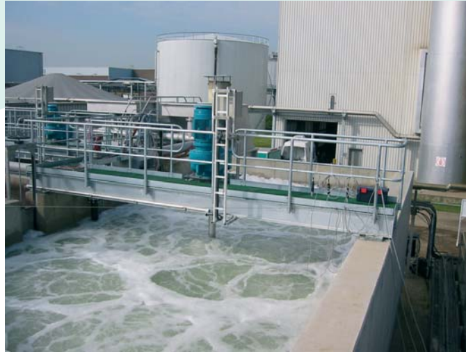
1 sistema de agitación/aireación HYPER-CLASSIC® de un total de 9 en una planta purificadora en Bélgica (Industria de papel y pulpa)
